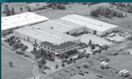
BOSECKER VERTEILERBAU SACHSEN GMBH, ZITTAU
