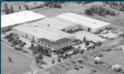
BOSECKER VERTEILERBAU SACHSEN GMBH, ZITTAU
