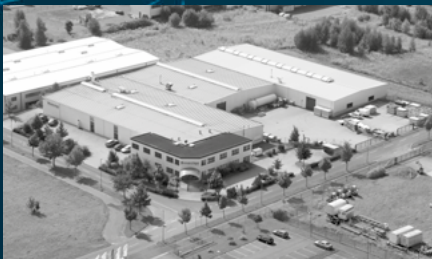
BOSECKER VERTEILERBAU SACHSEN GMBH, ZITTAU
